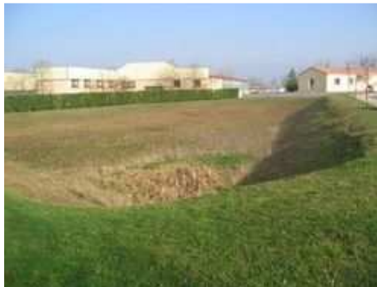
Figure 48. Illustration d'un bassin d'infiltration/régulation sec enherbé
