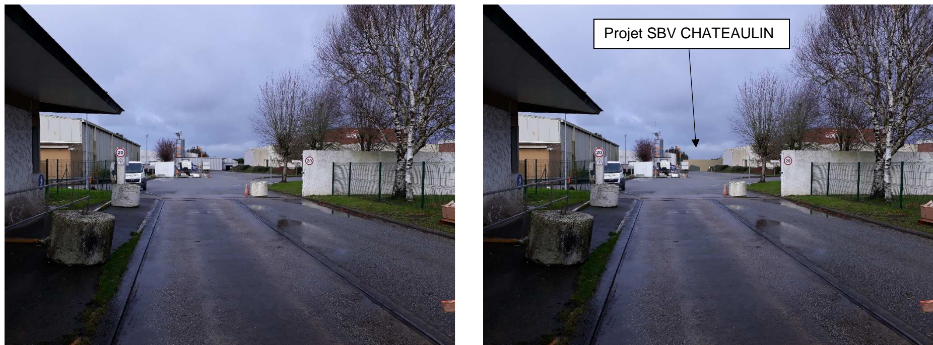
Vues de la STEP du site existant sur le projet SBV CHATEAULIN
