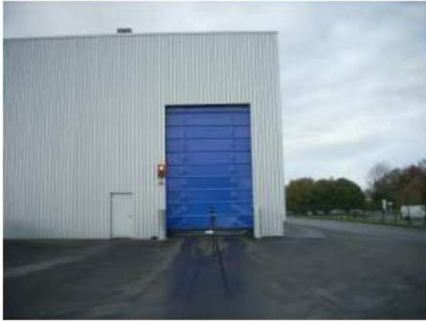
Figure 51. Photographie de la mesure sur le portail d'entrée « quai vifs »
